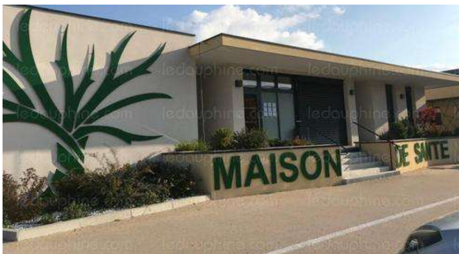
La maison de santé se trouve au cœur du centre bourg de la commune de La Bâtie-Neuve. Photo Le DL/Jean-Pierre Bonnet
